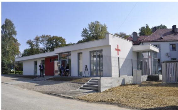
Ośrodek zdrowia w Groju wybudowany w 2017 roku. Fot. LCh
